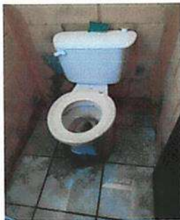
Foto 5: Situación actual de los sanitarios
